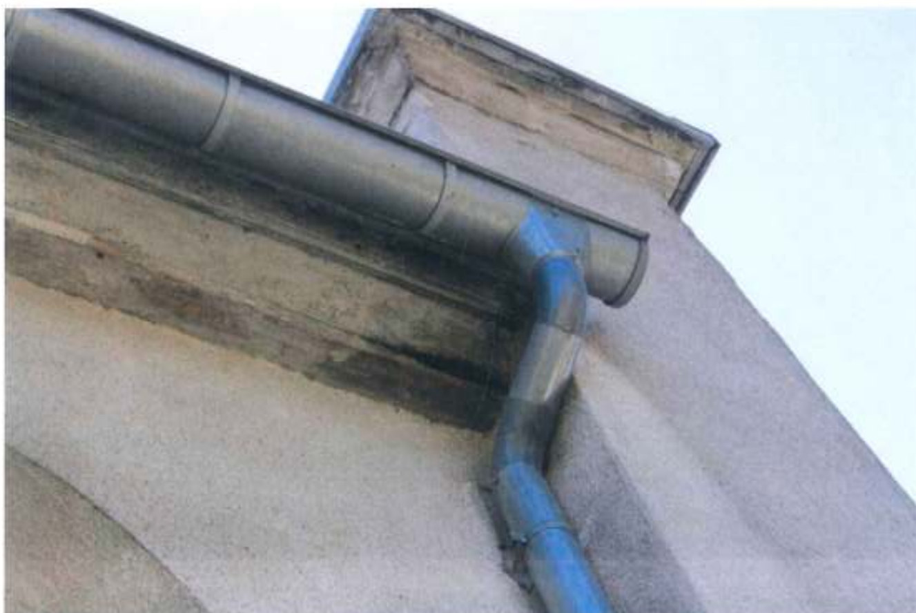
Widok zniszczeń okapu dachu.
