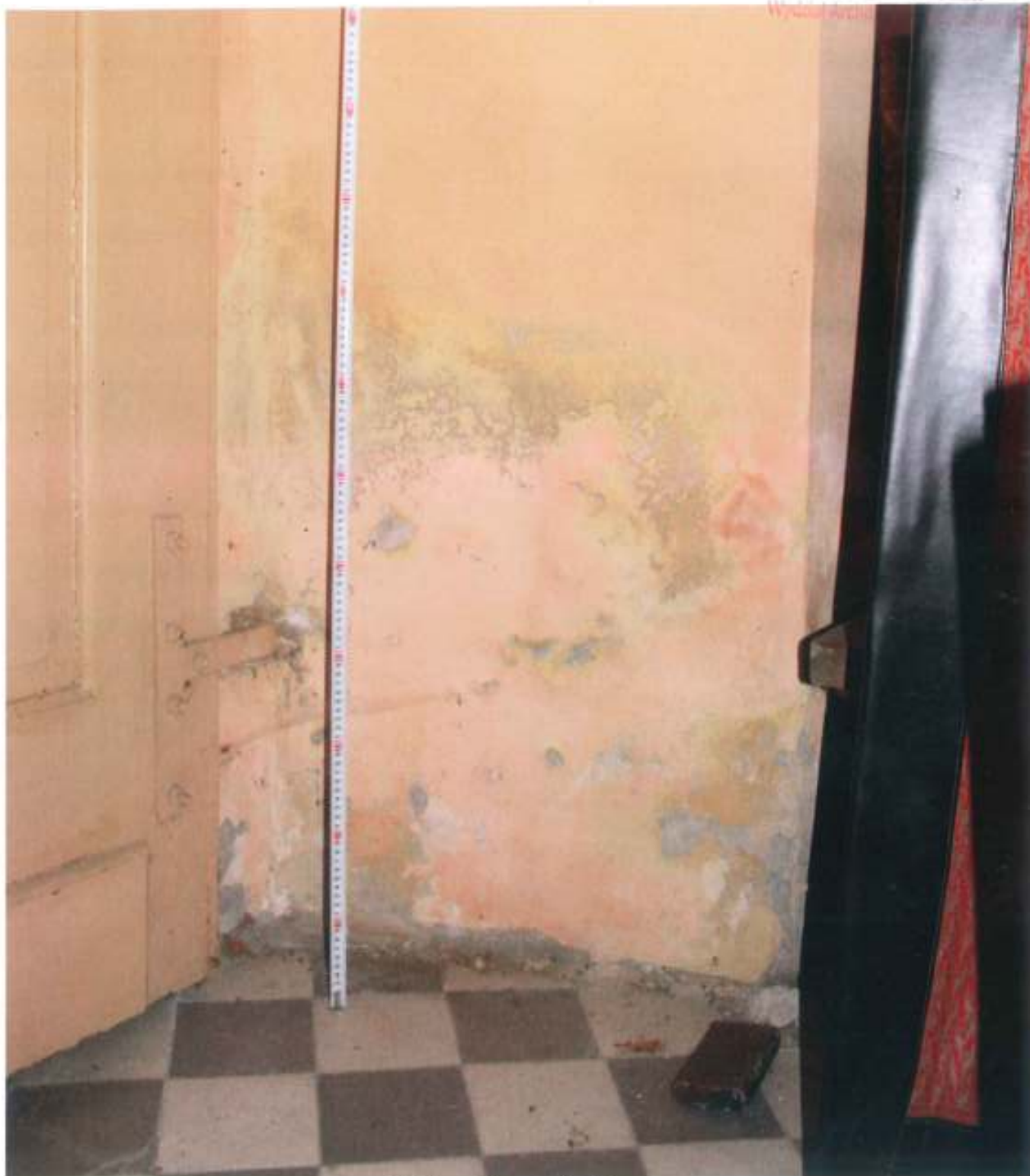
Widok zawilgoconych ścian.
