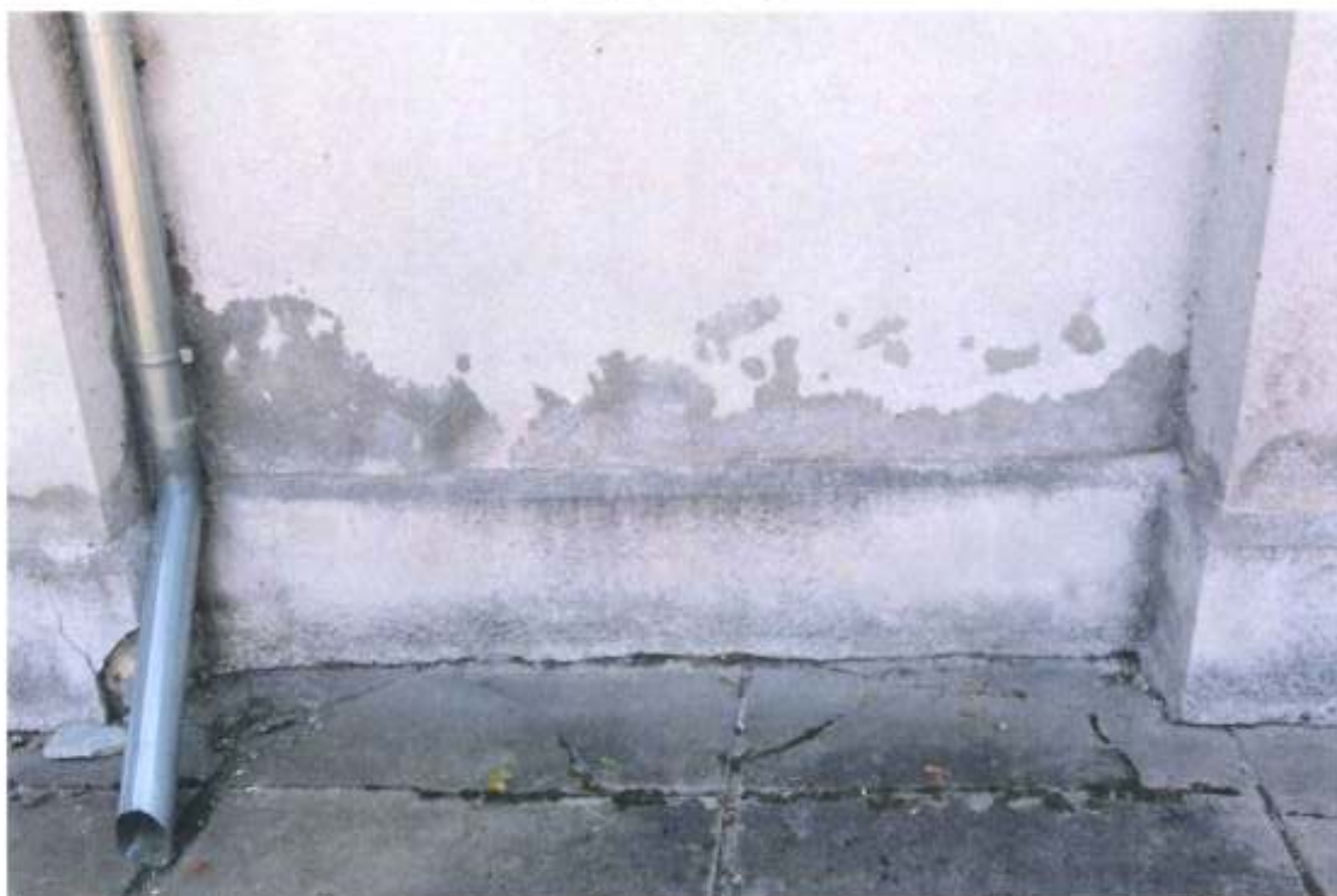
Widok uszkodzonego cokołu oraz chodnika betonowego.
