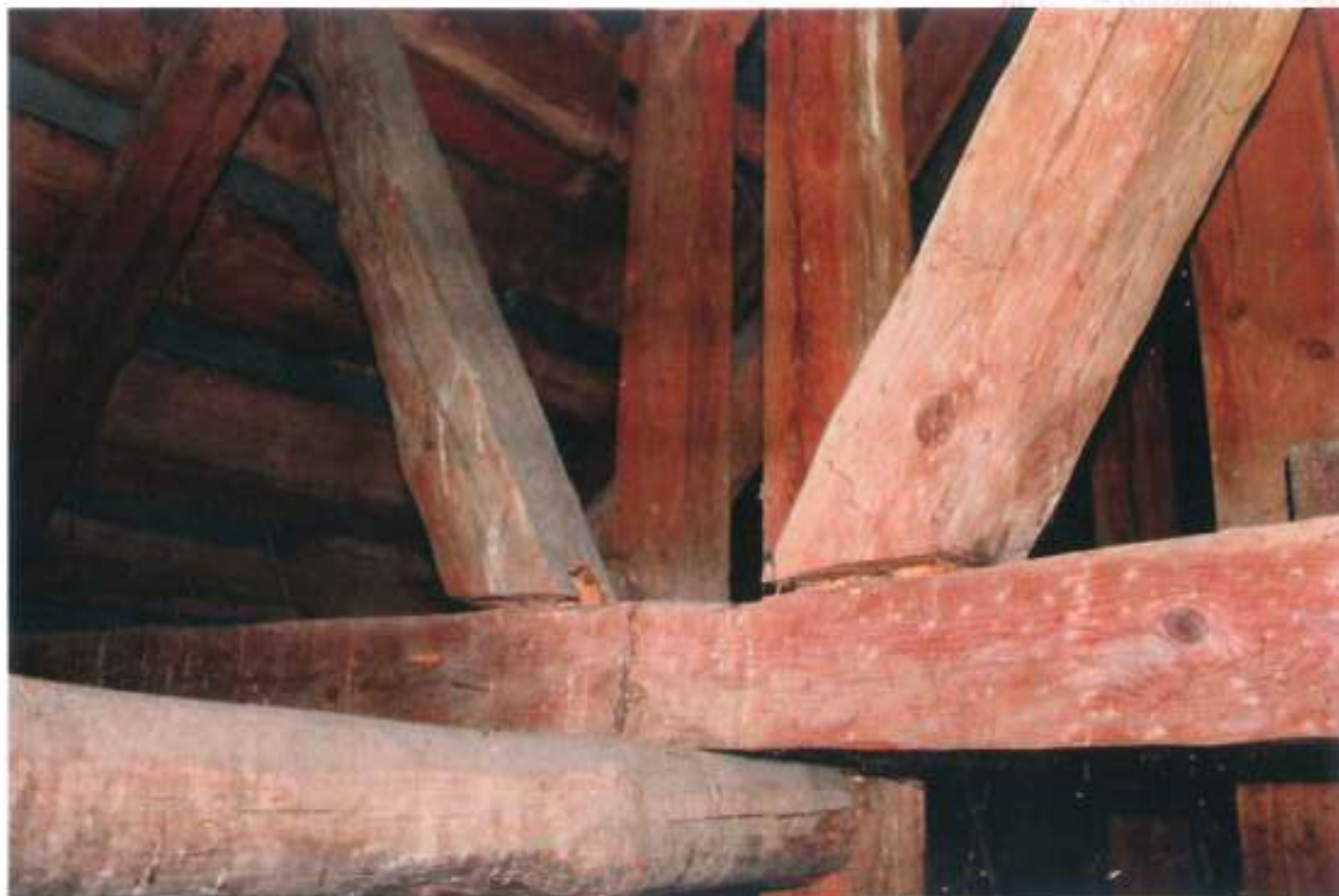
Widok rozluźnionych połączeń elementów konstrukcji dachu.
