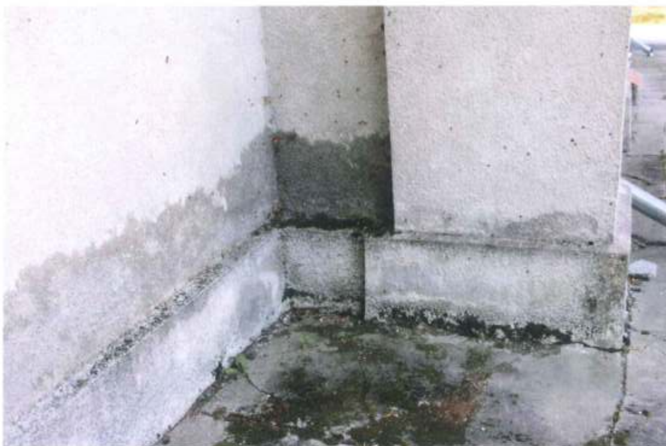
Widok zawilgocenia ścian zewnętrznych kaplicy.
