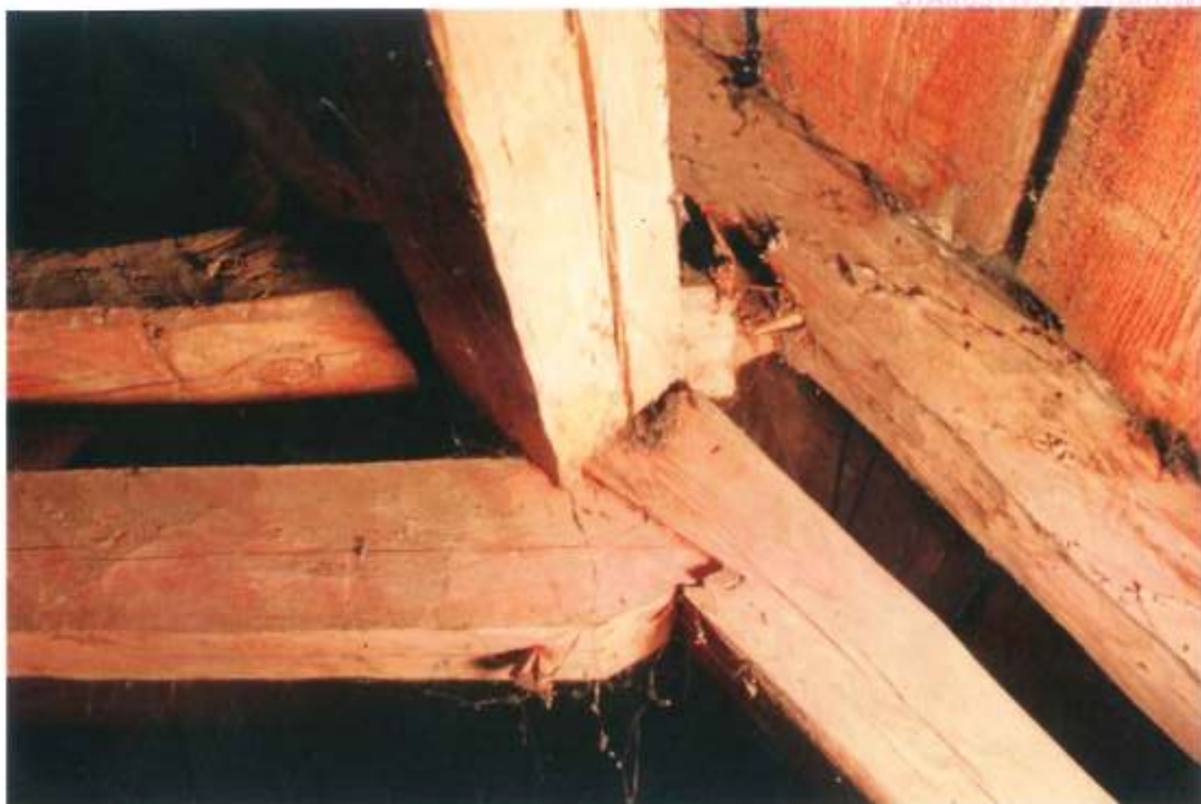
Widok rozluźnionych połączeń elementów konstrukcji dachu.
