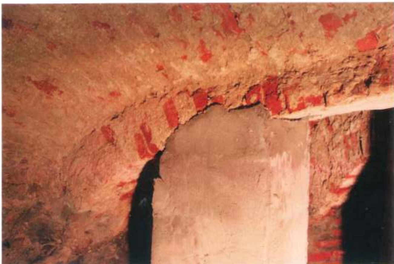
Widok wsporczoego słupa podtrzymującego sklepienie krypty.
