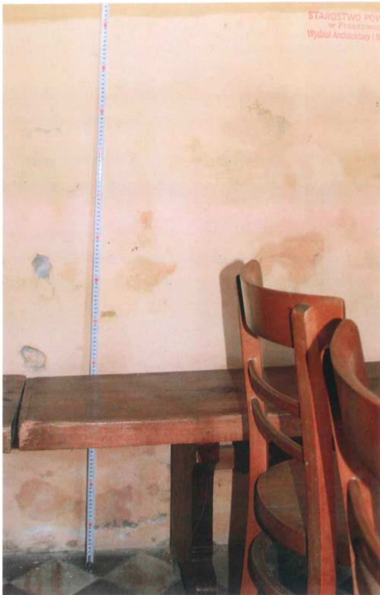
Widok zawilgoconych ścian.
