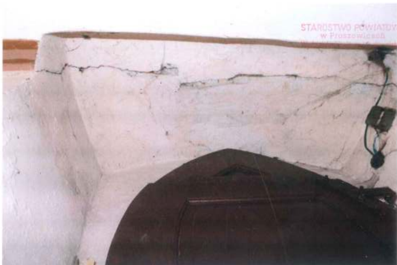
Widok pęknięcia nadproża nad drzwiami prowadzącymi z chóru na balkon.
