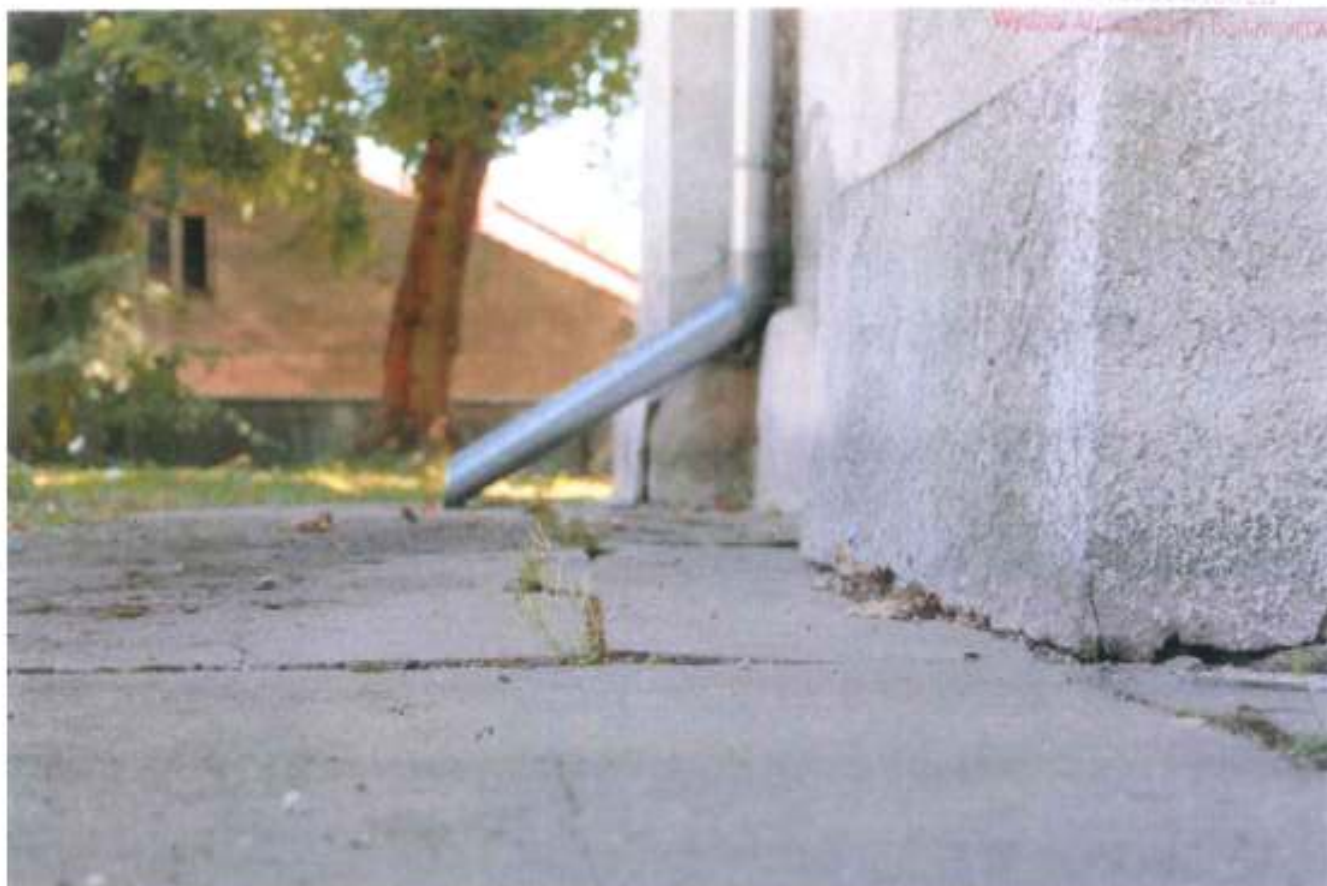
Widok spadku chodnika betonowego w kierunku kaplicy.
