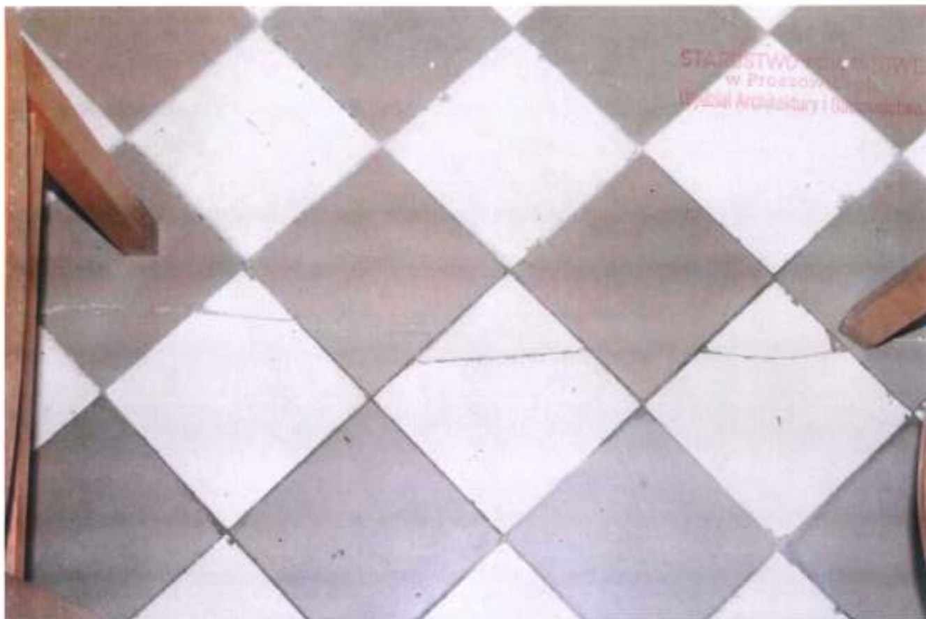
Widok uszkodzeń płytek posadzkowych.
