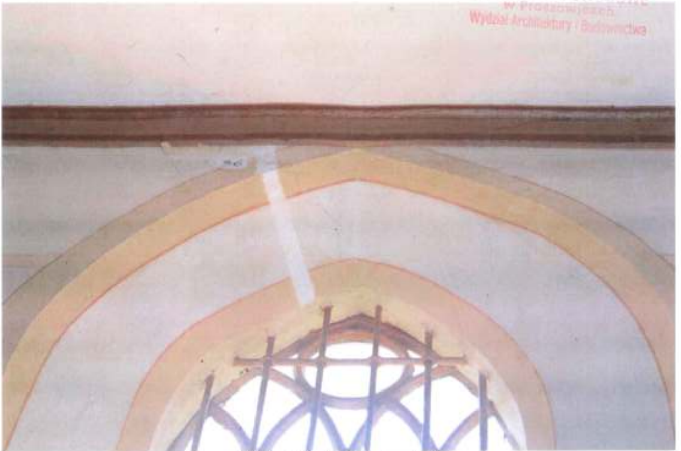
Widok pęknięcia ściany przy oknie.
