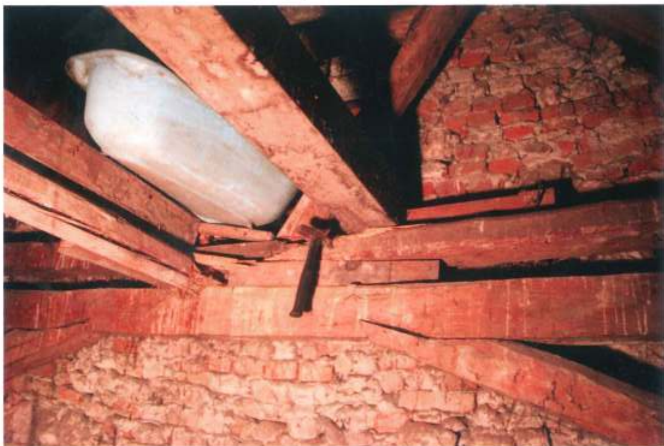
Widok zniszczonych połączeń elementów konstrukcji dachu.
