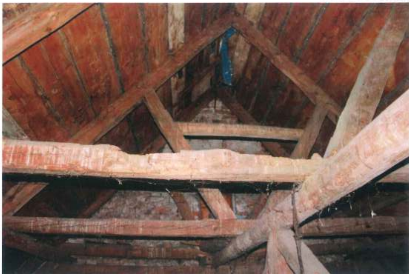
Widok skorodowanej drewnianej belki konstrukcji dachu.
