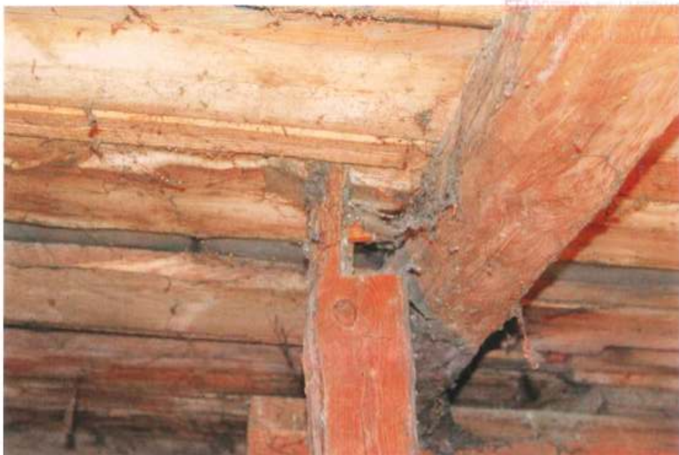
Widok zniszczonego połączenia elementów.
