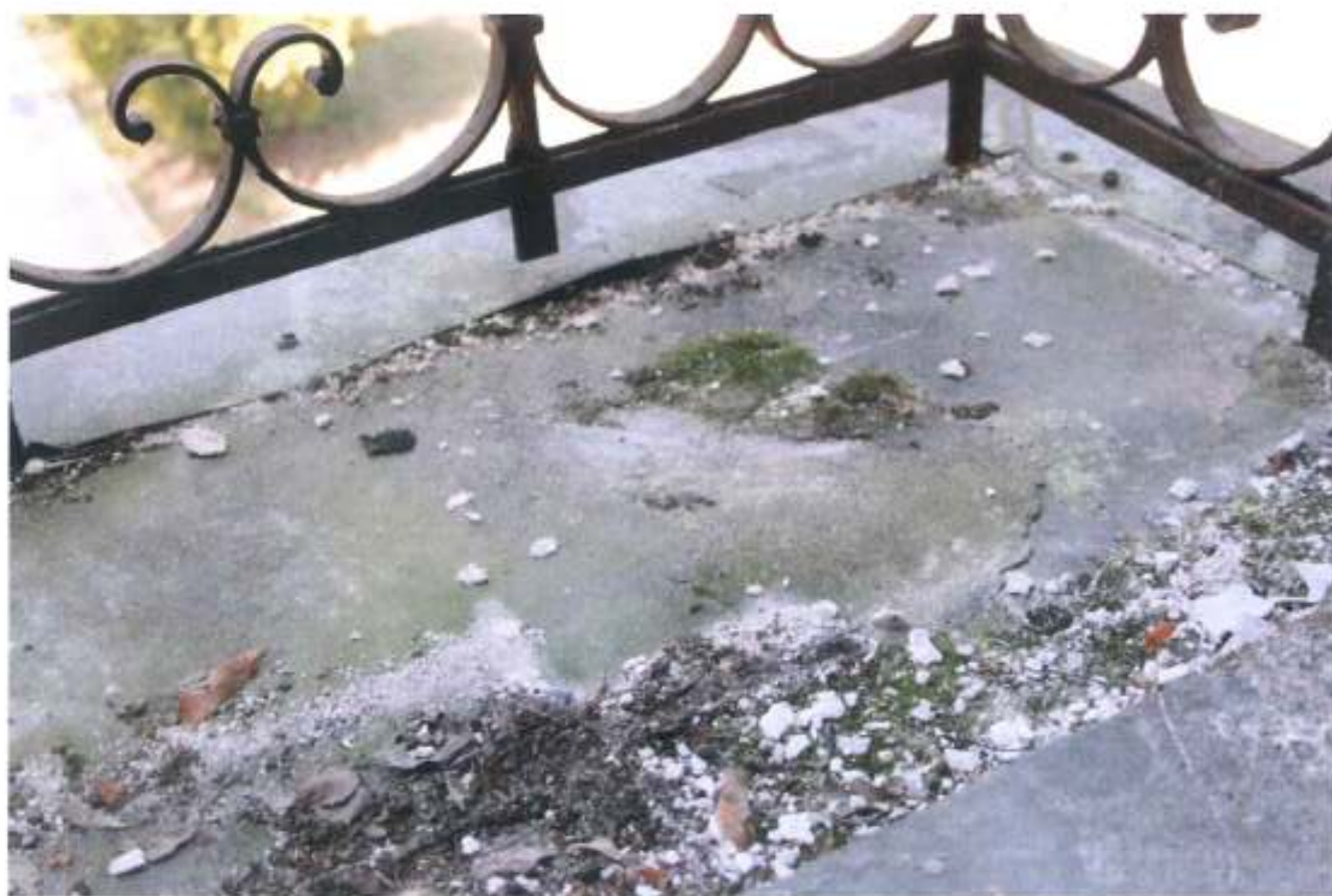
Widok uszkodzeń obróbek blacharskich i podłogi balkonu.
