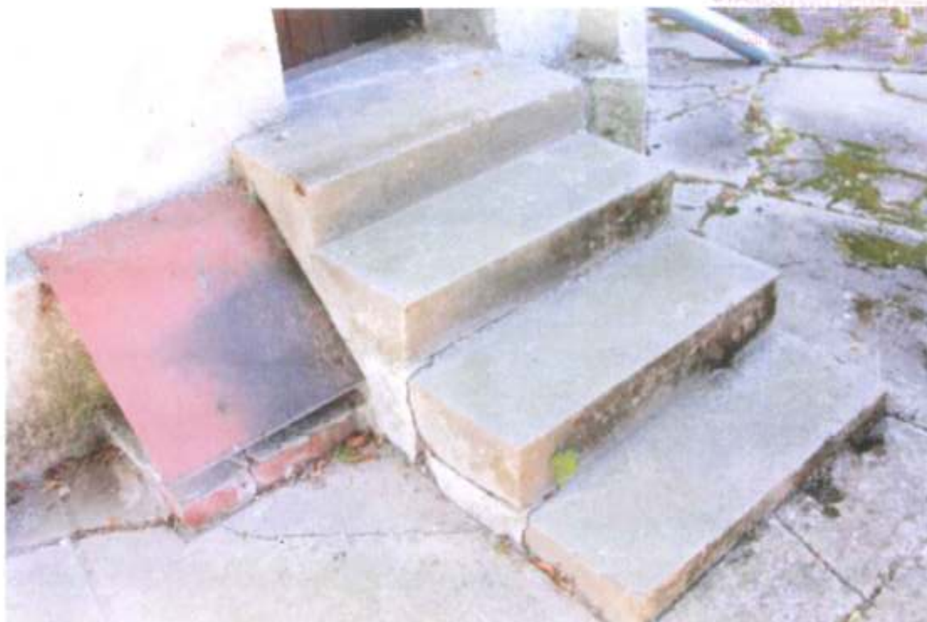
Widok uszkodzonych stopni prowadzących do prezbiterium.
