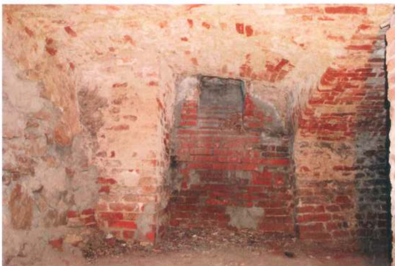
Widok ściany fundamentowej z otworem.
