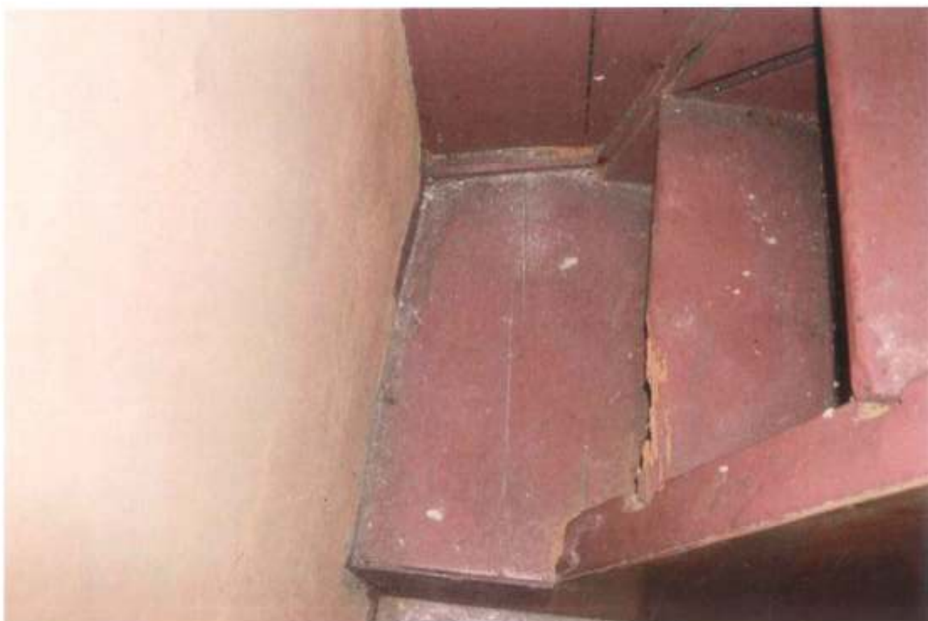
Widok uszkodzeń stopni prowadzących na chór.
