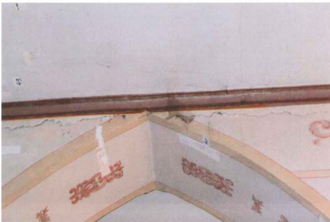
Widok pęknięcia ściany przy sklepieniu.
