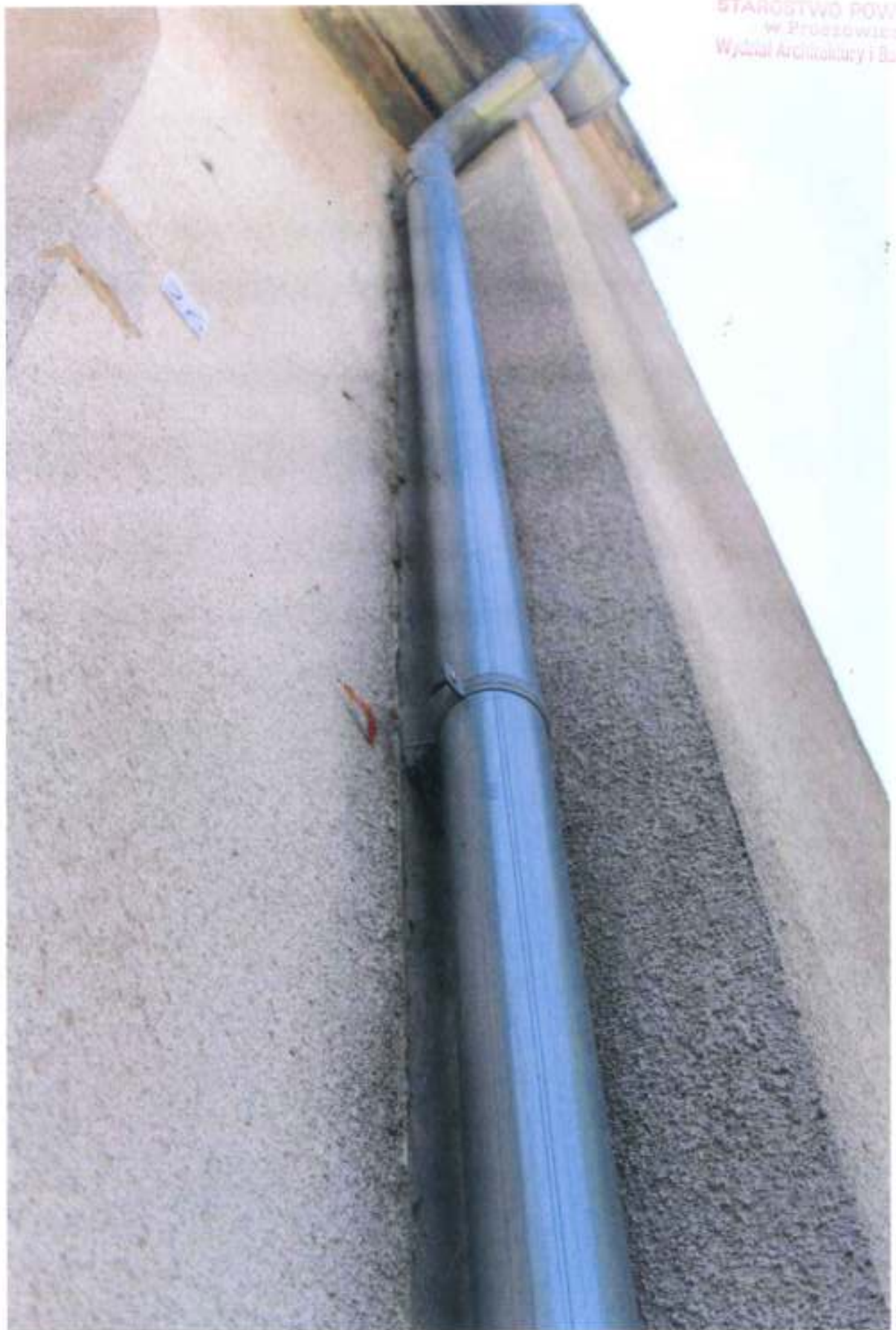
Brak tynku pod rynną.
