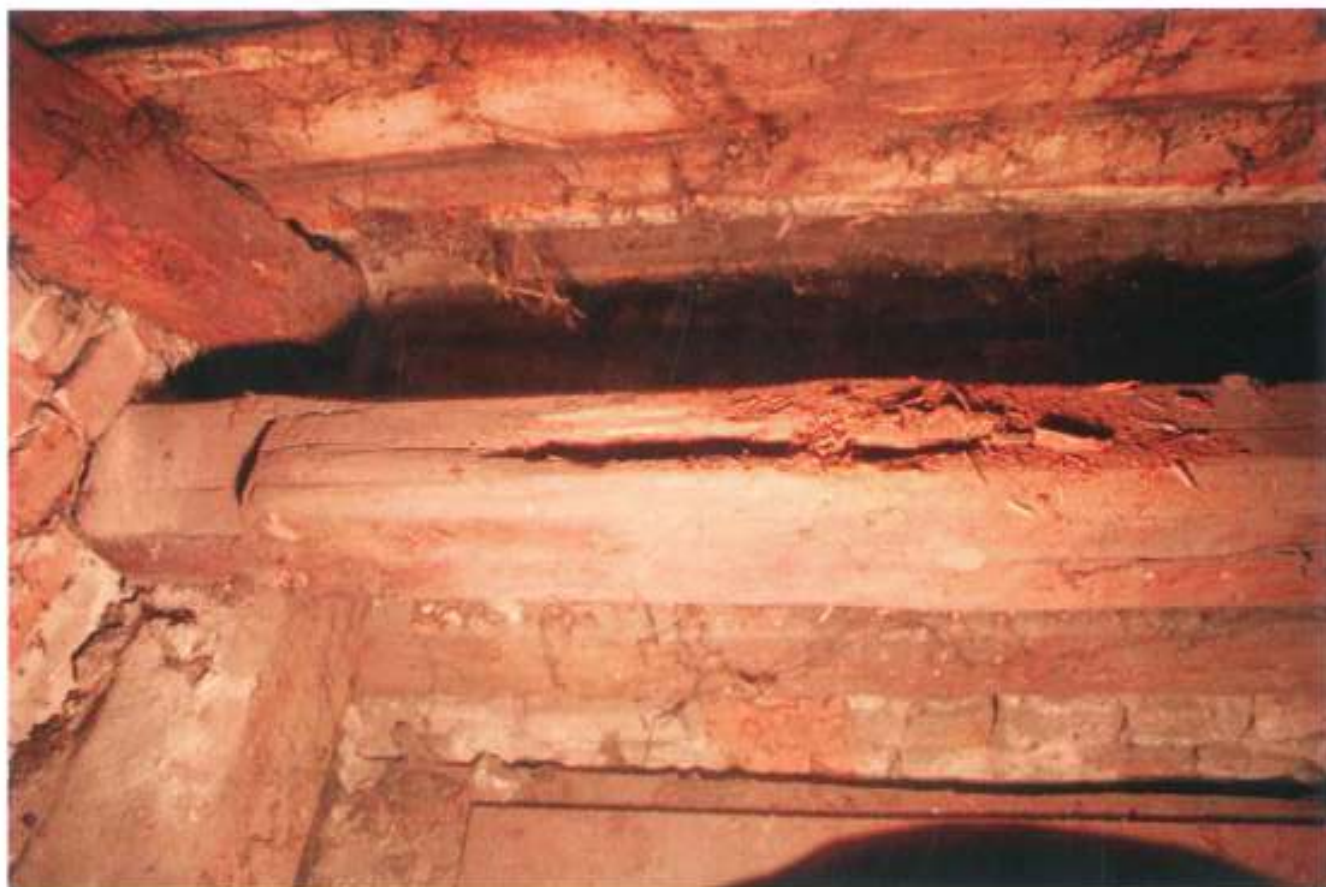
Widok zniszczonej drewnianej belki konstrukcji dachowej.
