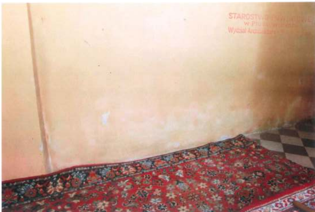
Widok zawilgoconych ścian.
