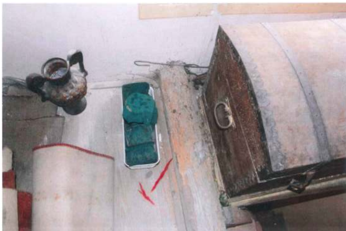
Widok uszkodzonej belki chóru.
