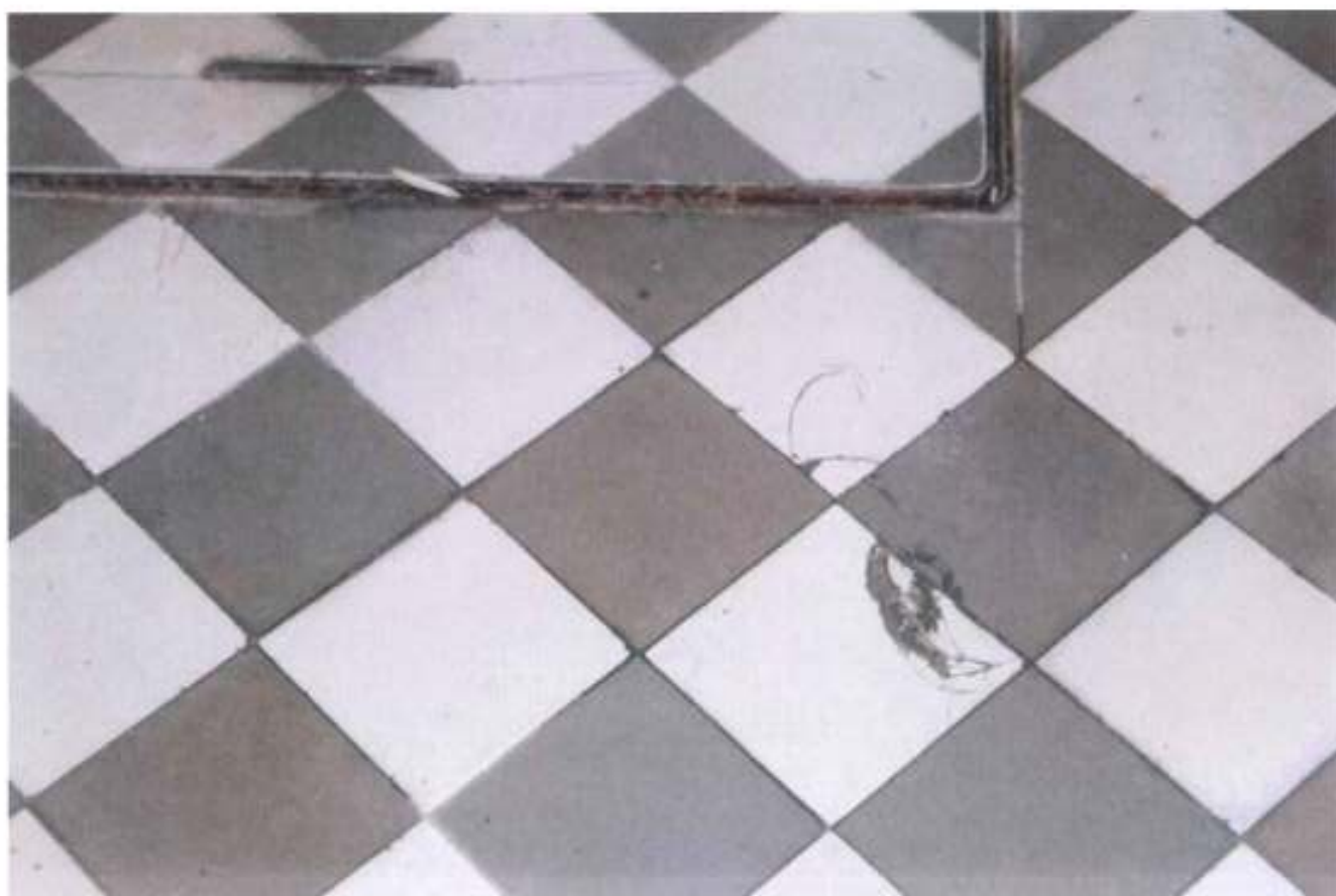
Widok uszkodzeń płytek posadzkowych.
