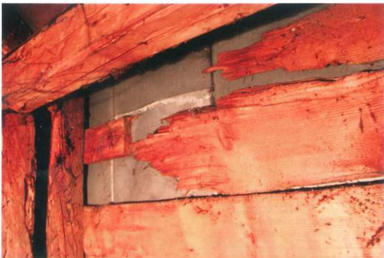
Widok wybrakowanego deskowania pokrycia dachowego.
